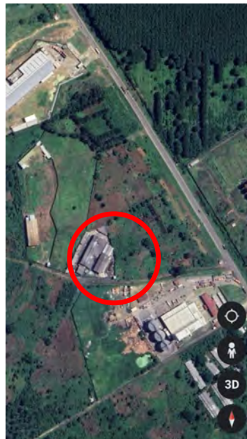
Graphique 3. GANESHA Cameroon Sarl (cercle rouge) usine située dans une zone agricole. Google Earth (2023) Douala https://earth.google.com/web/ (consulté le 18 juillet 2023).
