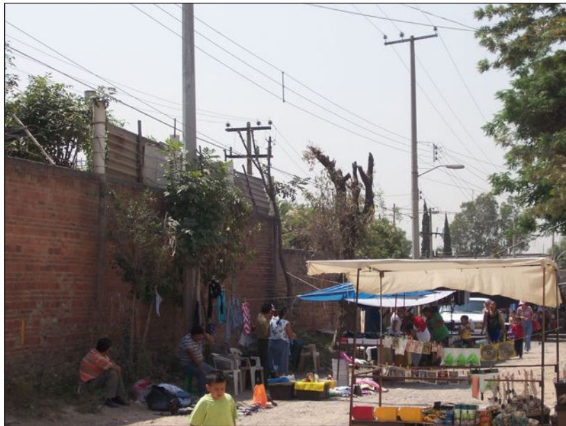
Figura 1. Barda de Industria de Acumuladores de Jalisco, Establecimiento Sin Autorización para el Reciclaje de Baterías de Plomo
